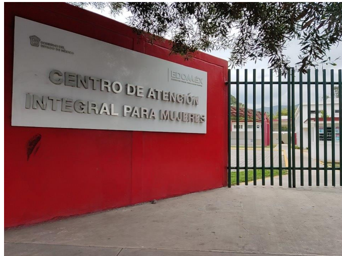
Imagen 10. Instalaciones del Centro de Atención Integral para Mujeres en Ecatepec, Estado de México
